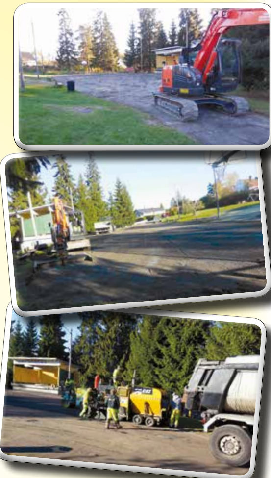
Det gikk unna med asfalteringen av parken. På det øverste bildet er asfalten fjernet, og ikke lenge etter var planeringen i gang. Etter tre-fire dager var asfalteringen fullført.
